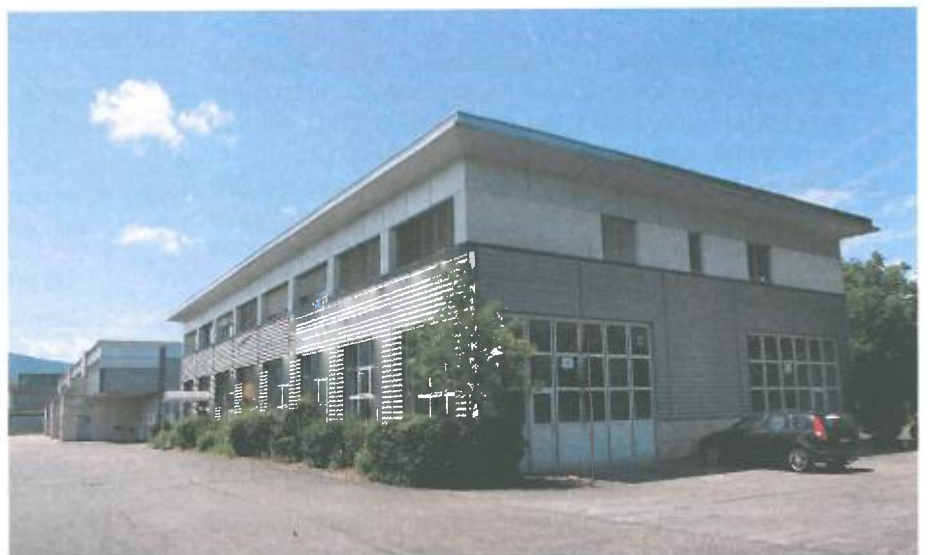
Bâtiment administratif existant
