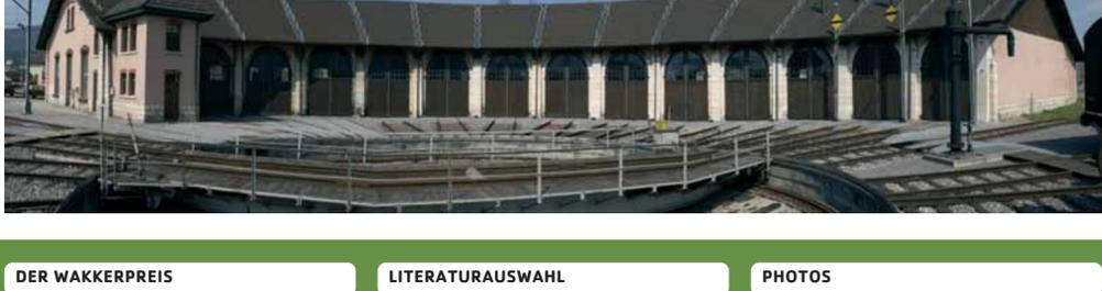
werkspfeilern und dem auffallenden, mit Nieten verbundenen Stahltragwerk (Polonceau-Binder) konnte dreizehn Lokomotiven aufnehmen. Durch eine Drehscheibe liessen sie sich von der Mitte aus verteilen. Nach der Aufgabe der Dampflokomotivdienste die Rotonde von Delémont als Reparaturwerkstätte. 1997 wurde sie anlässlich des 150. Geburtstags der SBB renoviert. Heute beherbergt sie ein privates Lokomotiv-Museum mit wahren Schmuck-
